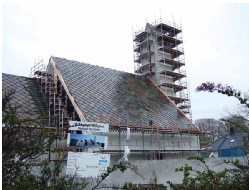
Budowa kościoła w Stavanger, stan na 10. maja 2012 r.
